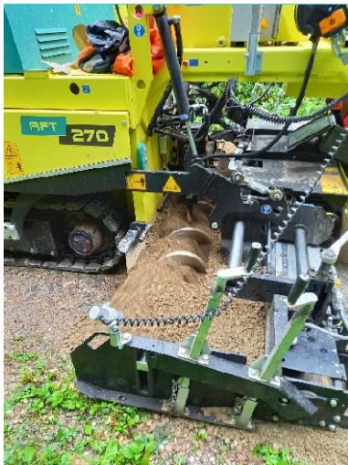
Einbau Strassen-Oberbau mit Einbaummaschine
